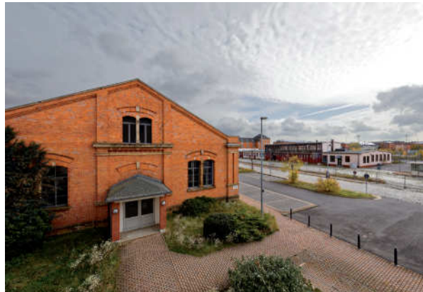
Historischer Gebäudebestand der ehemaligen Kaserne
